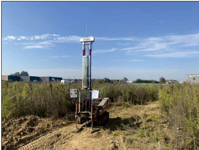
Figura 9: localizzazione ed esecuzione della prova penetrometrica dinamica n. 4, comune di Vaiano Cremasco (CR), via Nelson Mandela, il giorno 28/09/2023
